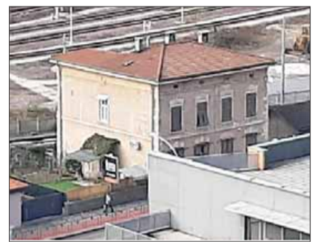
Lato ovest: un edificio residenziale
